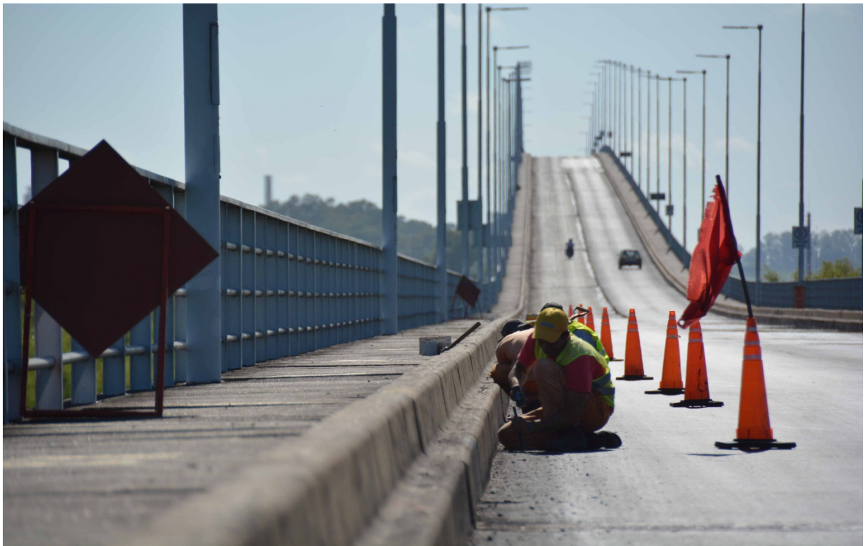
Obra de restitución de la carpeta asfáltica en el Puente General Artigas (PGA).
