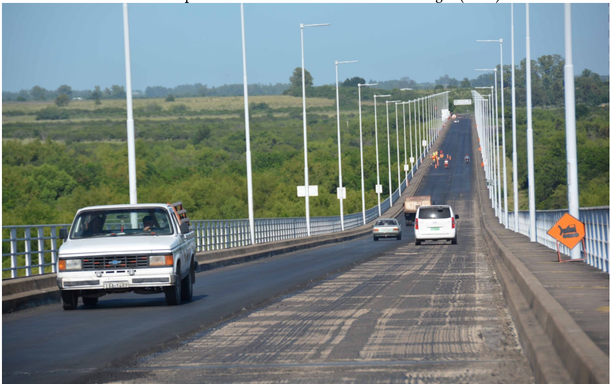
Para la restitución de la carpeta asfáltica se utilizó un producto que aumenta las propiedades de la mezcla
